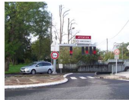
Tunnel pour les voitures.
